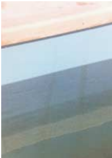
8. Utilización de una banda adhesiva no compatible con la membrana.
