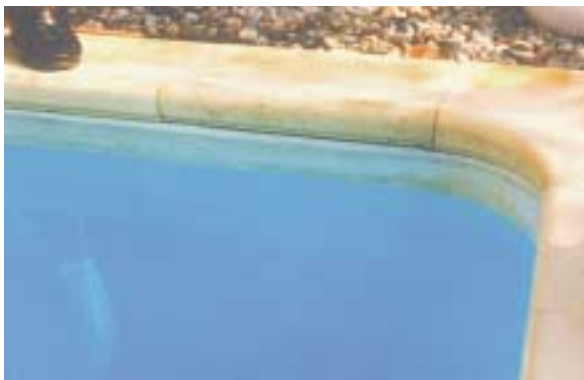
1. Formación de un depósito calcáreo en la línea del agua.
