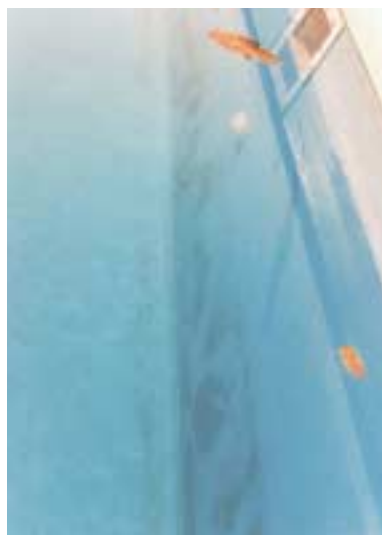
9. Los elementos de la pared contienen colorantes que migran dentro de la membrana de estanqueidad.
