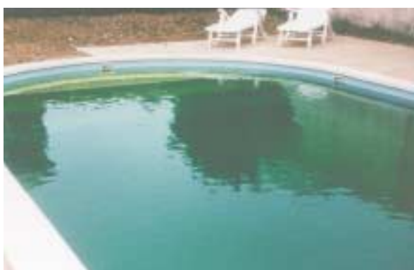
5. Presencia de algas verdes.
