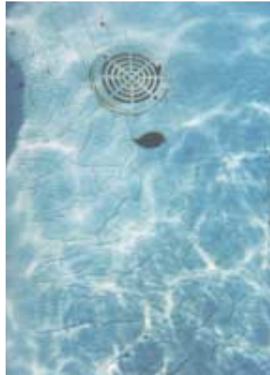
12. Formación de arrugas debidas a una mezcla insuficiente de los productos químicos en el agua.
