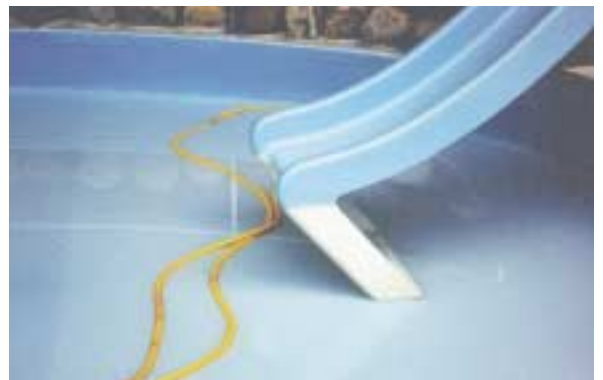
11. Ausbleichung durch aggressive Chemikalien.
