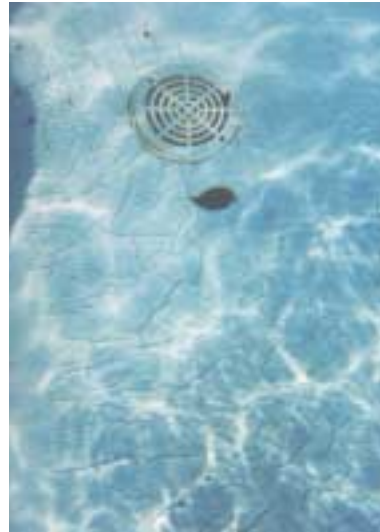
12. Faltenbildung durch schlechte Auflösung von Chemikalien.
